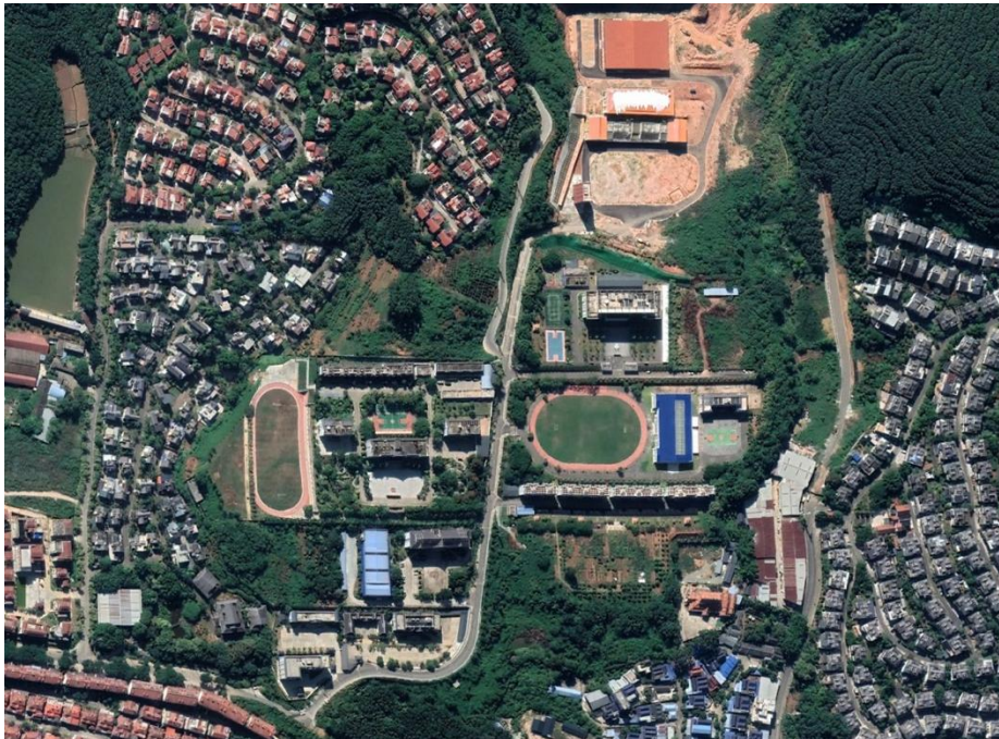
Figure n° 9 : VUE SATELLITE DU QUARTIER GENERAL DU CORPS DE PATROUILLE AQUATIQUE DU YUNNAN A JINGHONG
