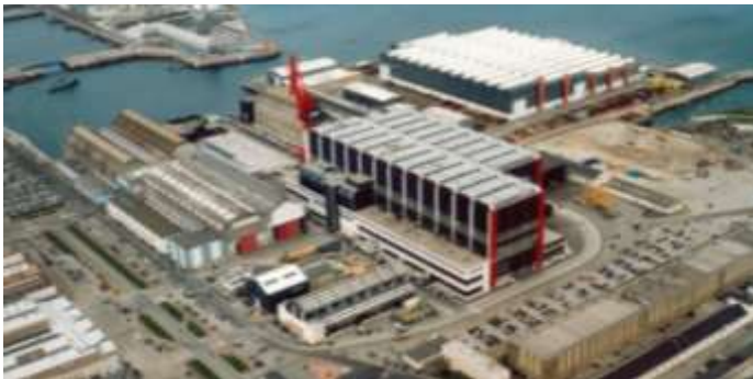
Chantier de Cherbourg
